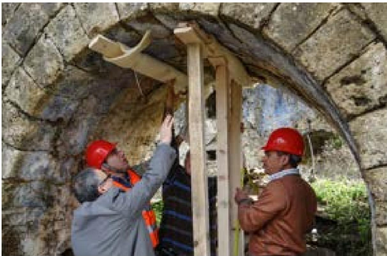
تثبیت شرایط اضطراری در عمل در کارگاهی در شوف، لبنان، ۲۰۱۴. عکس: ICCROM-ATHAR.
