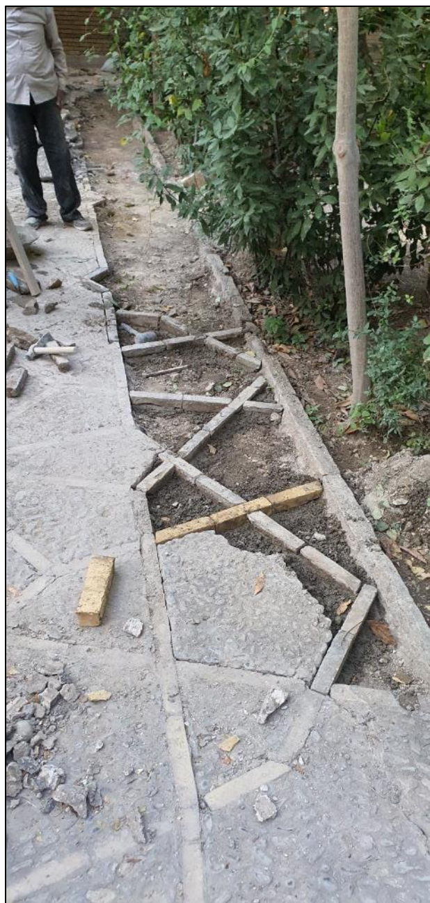
حمیل کشی و نصب بندهای آجری و اجرای قلوه سنگ در لقاط کف فرش حیاط شمالی
