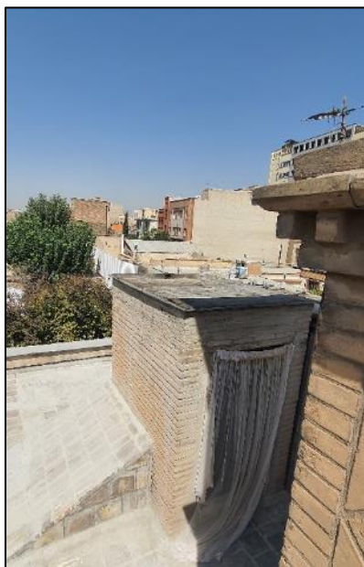
اجرای ایزولاتور قیری بر جوانب خرپشته ها
