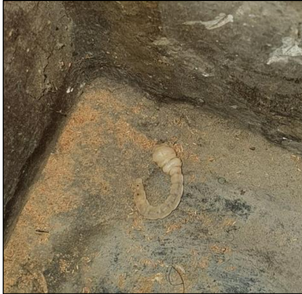
لارو زنده آنویوم پانکتاتوم در پای کلاف چهارچوب بازشوی بادگیرها
