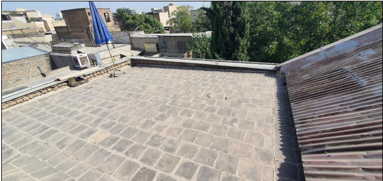
بام شرقی پیش از برچیدن آجر فرش
