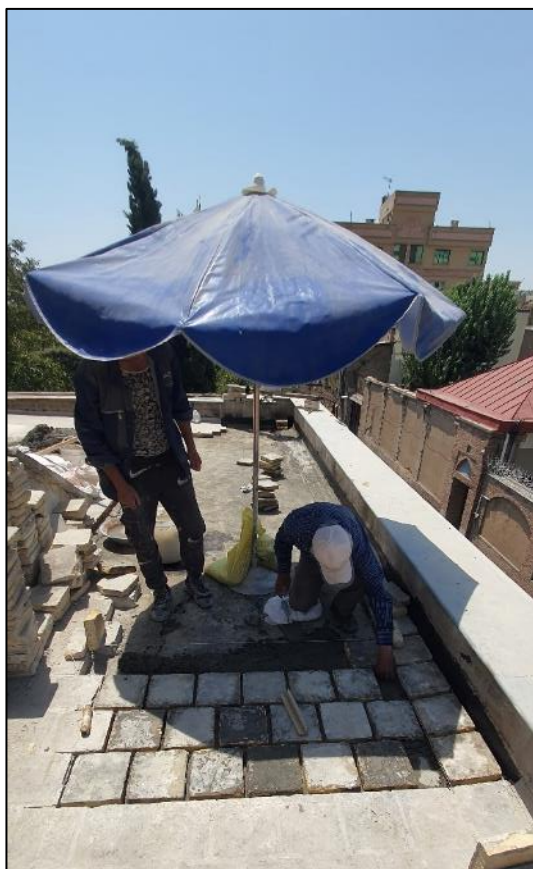
اجرای آجر فرش بام ها
