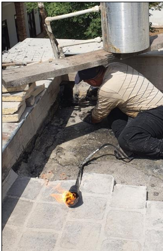
اجرای ایزولاتور قیری بر کف خواب ناودان ها
