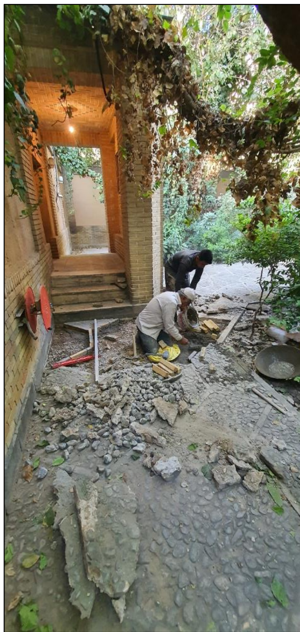
حمیل کشی و نصب بندهای آجری و اجرای قلوه سنگ در لقاط کف فرش حیاط شمالی
