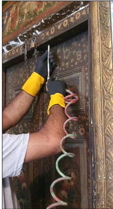
دمش هوای فشرده در حفرات به منظور پاکسازی کانال ها از بقایای فعالیت آفت چوبخوار
