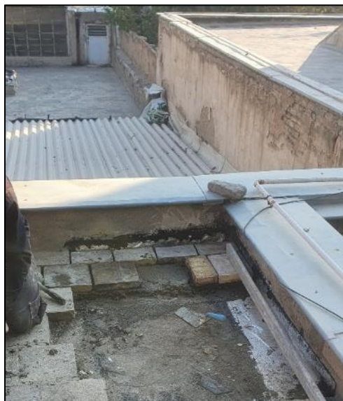
اصلاح ایزولاسیون و اجرای آجر فرش بام بنای وجه شرقی حیاط عمارت
