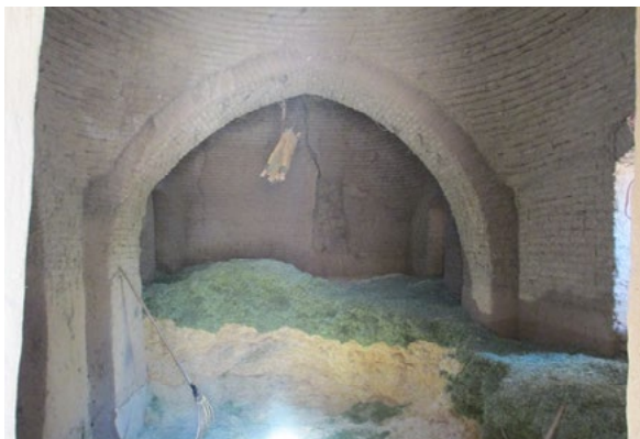
تصویر شماره ۲۵: انبار علوفه.
