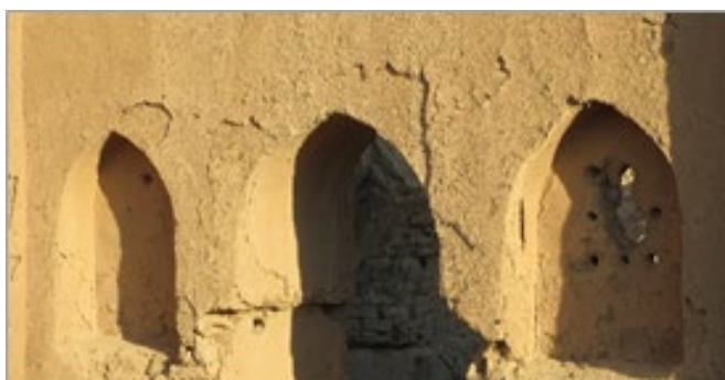
تصویر شماره ۸: روزن‌های موجود در دیوار.
