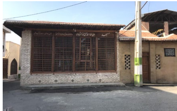
تصویر شماره ۹: نمای جبهه جنوب شرقی مسجد ملا اسماعیل در محله درب نو پس از مرمت.
