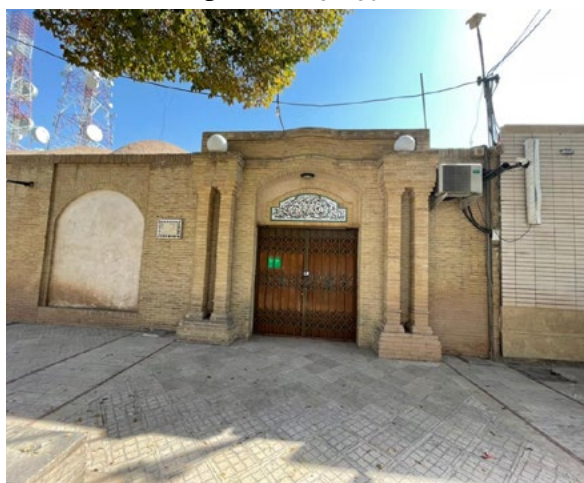
تصویر شماره ۱۱: نمای شمالی ورودی اصلی.
