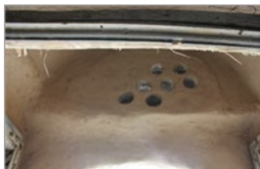
تصویر شماره ۷: روزن‌های موجود در دیوار.
