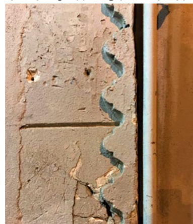
تصویر شماره ۲۷: تزئینات حداقلی مسجد در جبهه شمال غربی مسجد رئیسی در محله درب نو.
