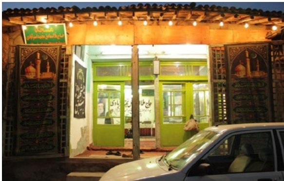
تصویر شماره ۱۰: نمای جبهه جنوب شرقی مسجد ملا اسماعیل در محله درب نو پیش از مرمت.
