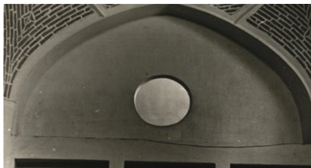
تصویر شماره ۱۲: مسجد پایین روزنه‌ای که از طریق اتصال به بادگیر تهویه مسجد را انجام می‌دهد، نیمه اول دهه ۵۰. مأخذ: مرکز اسناد دانشگاه شهید بهشتی.
