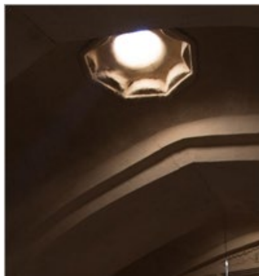
تصویر شماره ۵: نمونه‌ای از هورنو موجود در سقف.
