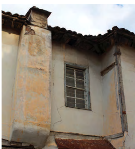
تصویر شماره ۷: دودکش در نمای یک ساختمان مسکونی در وریا و پنجره‌ای با دو بازشوی عمودی متحرک (محقق، ۲۰۱۳).
