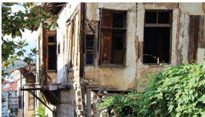
تصویر شماره ۵: یک ساختمان مسکونی قدیمی در وریا که ساختار معماری بومی آن قابل شده است (محقق، ۲۰۱۳).
