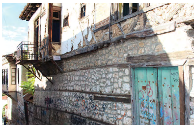
تصویر شماره ۶: ساختار یک ساختمانی مسکونی در وریا که سنگ‌های تراش تقویت شده در طبقه همکف آن قابل مشاهده است (محقق، ۲۰۱۳).
