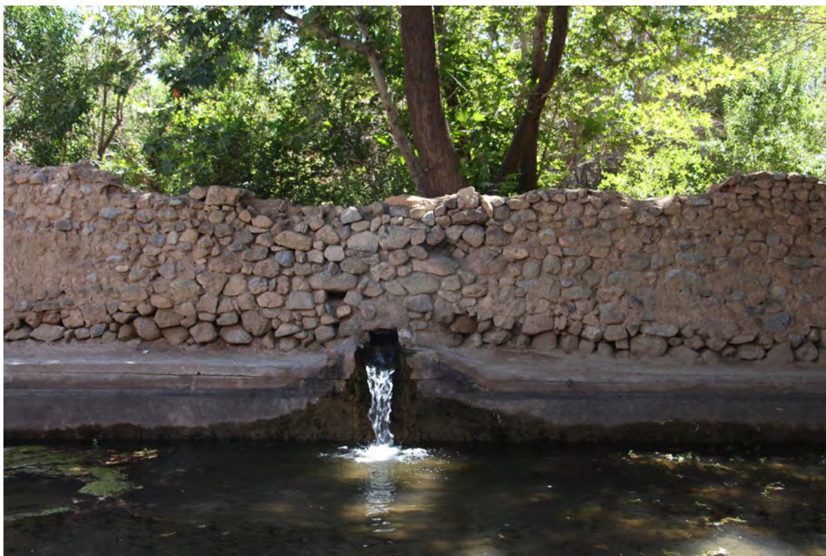
تصویر ۱۰ دیوار سنگ چین با ملات گل. روستای بنادک سادات. مرداد ۱۳۹۸.
