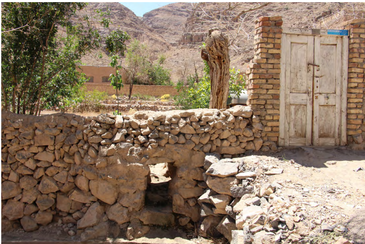
تصویر ۲۱. دیوار سنگ چین به صورت خشکه چین و ملات گل در اطراف کانال آب. عبور مسیر آب از میان دیوار درخور توجه هست. روستای هنزا، مرداد ۱۳۹۸.
