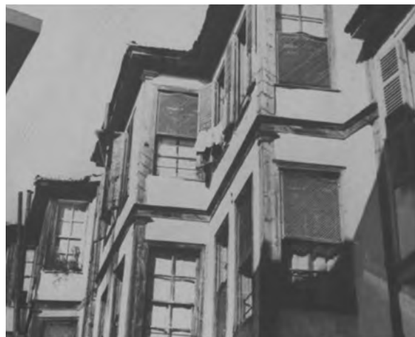
تصویر ۳ و ۴ - سمت چپ: تقسیم عمودی یک ساختمان در آناتولی به نیمه زمستان (راست) با پنجره‌های کوچک و نیمه تابستان (چپ) با دهانه‌های بزرگ‌تر. منبع: (Küçükerman, 1996)، سمت راست: عناصر سایه‌انداز در سبک عثمانی در تسالونیکي توسط کرکره (سمت راست در تصویر) آویزان شده اند. منبع: (Moutsopoulos, 1979)
