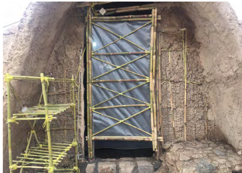
تصویر ۱۲- ساخت در، پنجره و میلان مورد نیاز با نی منبع: نگارنده.
