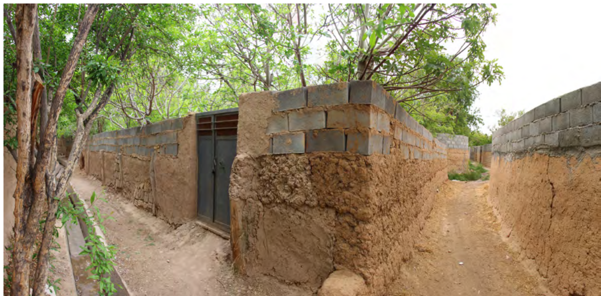
تصویر ۲۳. افزایش ارتفاع جداره باغ‌ها با استفاده از بلوک‌های سیمانی. مهریز محله مزویرآباد، فروردین ۱۳۹۸.
