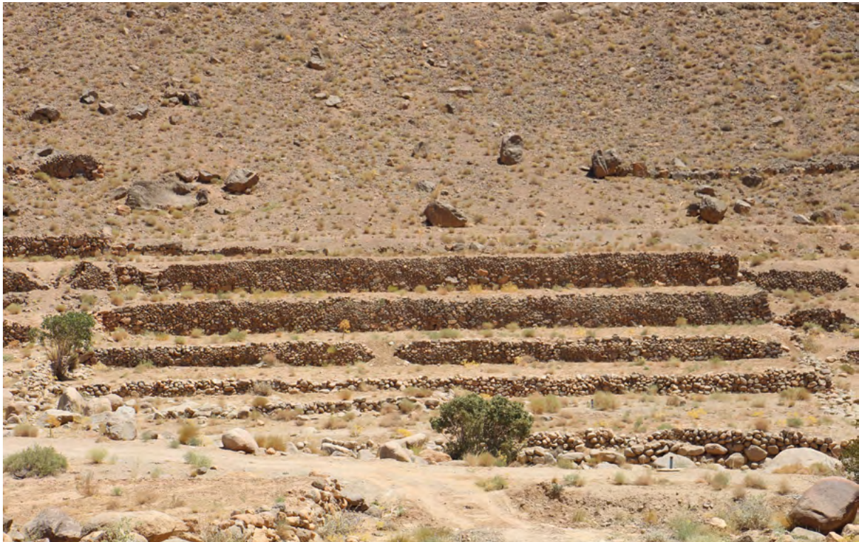
تصویر ۲۲. اجرای دیواره سنگ چین و ایجاد تخت‌گاه‌ها برای حفظ خاک و ایجاد امکان کاشت محصول در شیب تند دامنه‌ی کوه. اغلب این اراضی و تخت‌گاه‌ها در دهه‌های گذشته زمین‌های کشاورزی بوده و در سال‌های اخیر لم یزرع و بایر شده‌اند. روستای هنزا، مرداد ۱۳۹۸.
