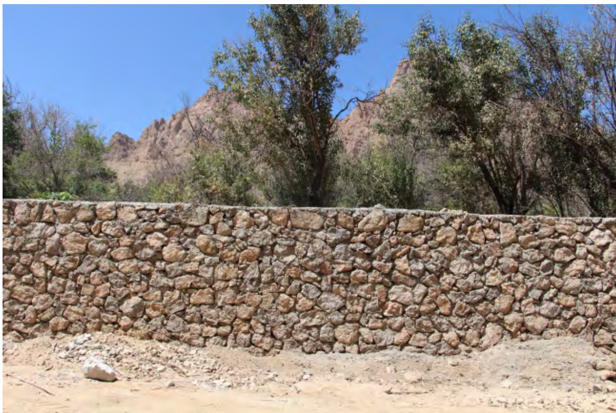
تصویر ۳۰. دیوار سنگ چین با ملات ماسه سیمان. روستای بنادک سادات، مرداد ۱۳۹۸.
