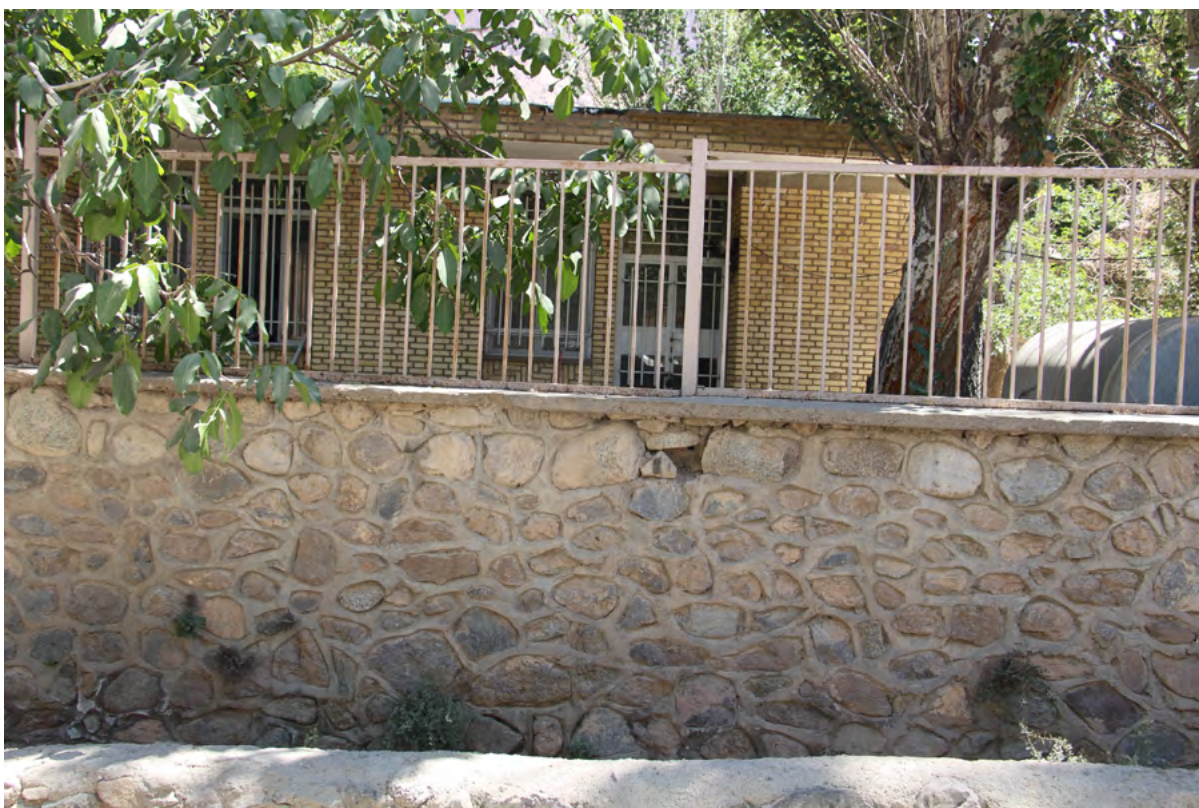
تصویر ۲۹. دیوار سنگ چین با ملات سیمان و بندکشی برجسته با نرده فلزی. تجارب نهادها و ساختمان های دولتی در سالهای گذشته در ساخت حصار و جداره بیرونی محوطه. روستای بنادک سادات، مرداد ۱۳۹۸.
