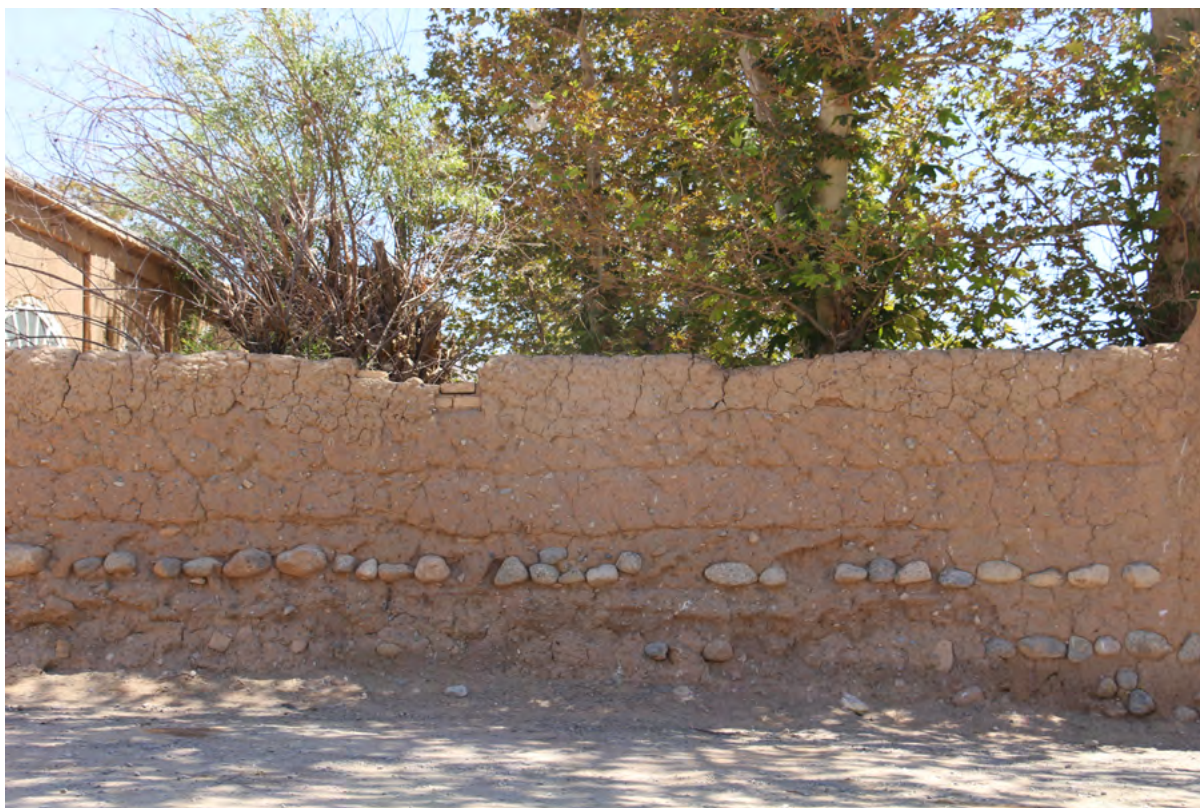
تصویر ۶ دیوار چین با استفاده محدود سنگ به صورت رگ چین در بین چین‌ها. مرداد ۱۳۹۸
