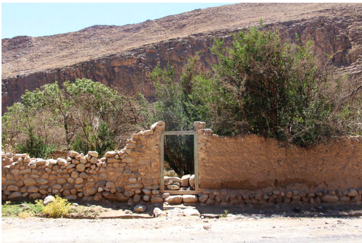
تصویر ۷. اجرای حصار با ترکیب دیوار سنگ چین و دیوار چین. مهریز، روستای فخرآباد. مرداد ۱۳۹۸
